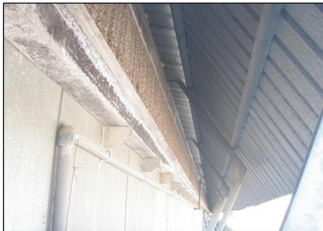
Photo 5 : Humidificateurs de type « pad-cooling » (photo personnelle)
