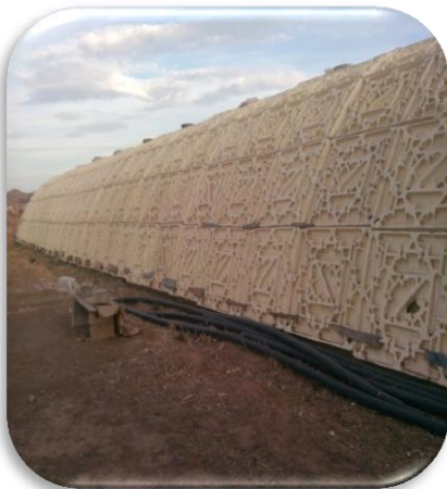
Vue extérieur du bâtiment (vue latérale)
