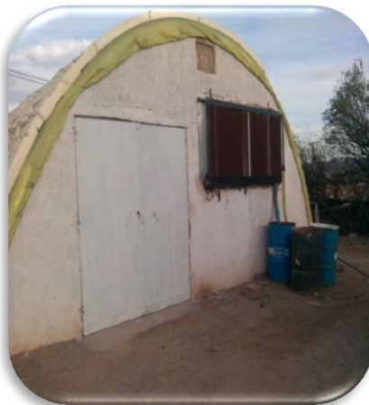
Vue extérieur du bâtiment (profil)
