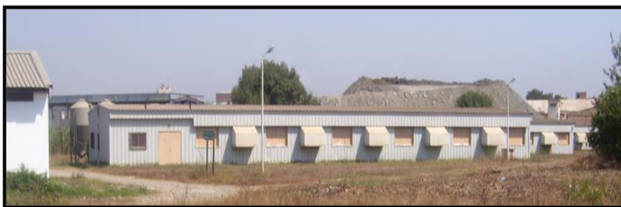
Figure 5 : Vue extérieure du bâtiment d'élevage
