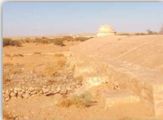
Photo 19 : Djoub au niveau d'Oued Nssa (système de collecte d'eau) (photo personnelle, 2018)
