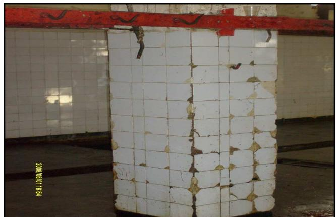
**Photo 11.** Des faïences altérés au niveau des piliers de l'abattoir d'El-Harrach (Original)
