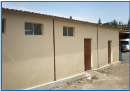
Figure 14 : Extérieur du clapier.
