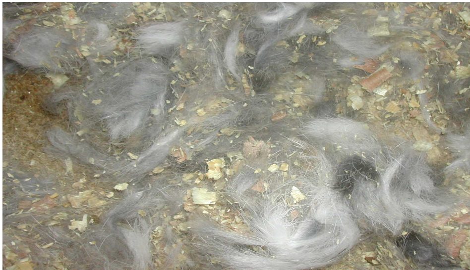
Figure 38 : Mise en place des copeaux du bois.
