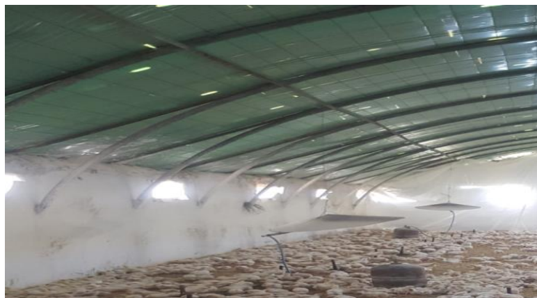
Figure 2 : Intérieur du bâtiment d'élevage (Photo personnelle)
