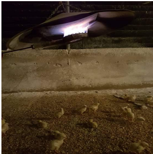
Photo 8 : Radiant assurant le chauffage
