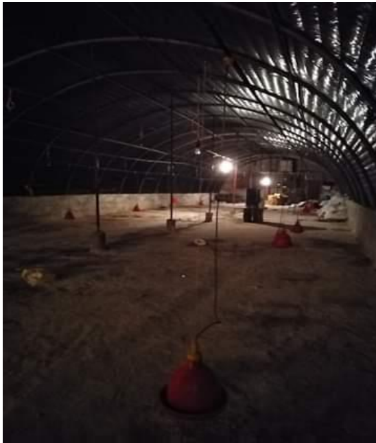
Photo 1 : Bâtiment avicole de l'intérieur
