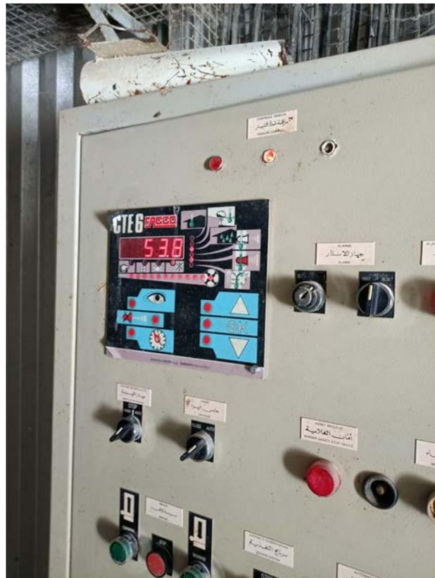
Figure 25 : Hygromètre intégré dans le tableau de commande (photo personnelle)
