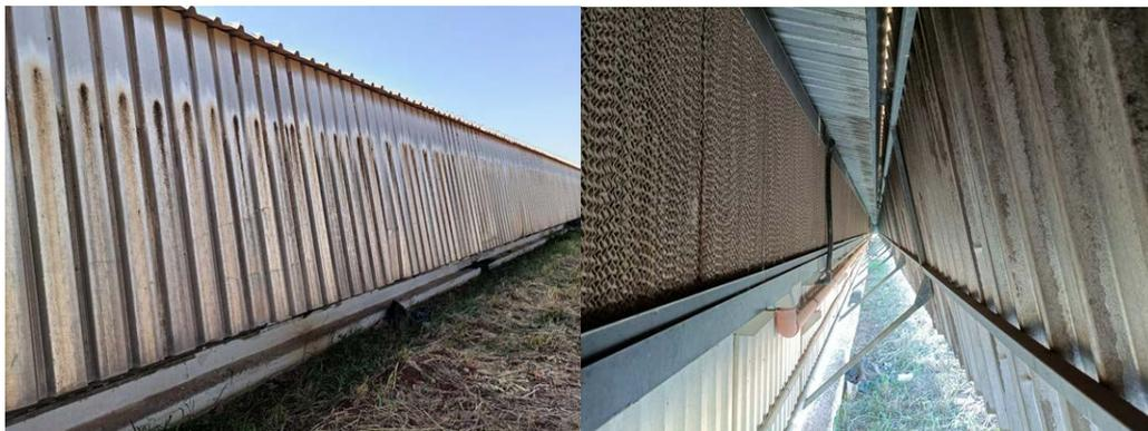
Figure 23 : Humidificateurs (pad-cooling) (photo personnelle)
