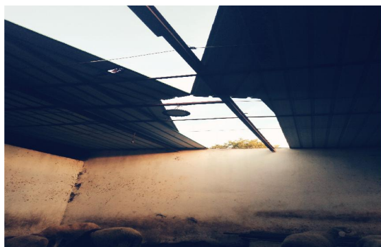
Figure 2 : toiture défectueuse compromettant l'isolation thermique (Photo originale).
