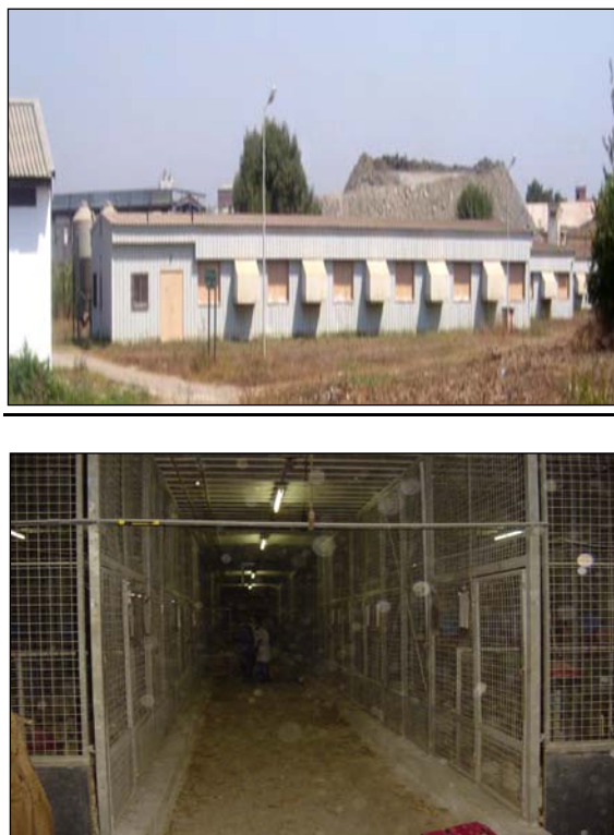
Figure 10. Vues (extérieure et intérieure) du bâtiment d'élevage utilisé pour l'essai.
