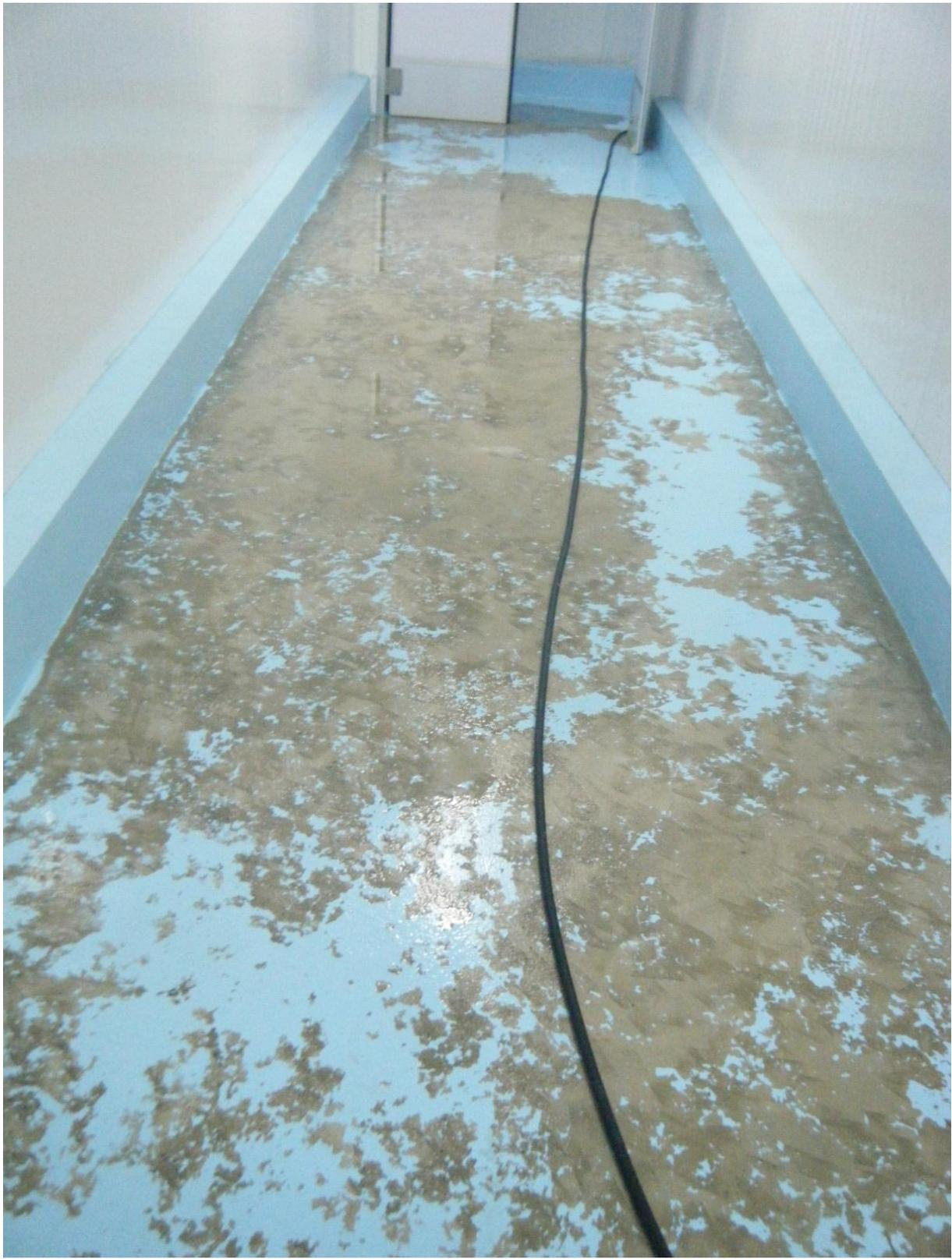
**Photo 5 : Béton recouvert de peinture polyuréthane mais écaillée. NCm**
