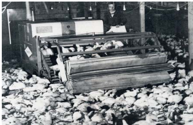
Figure n° 02 : Système de ramassage automatisé (N. Korsak, 2007)
