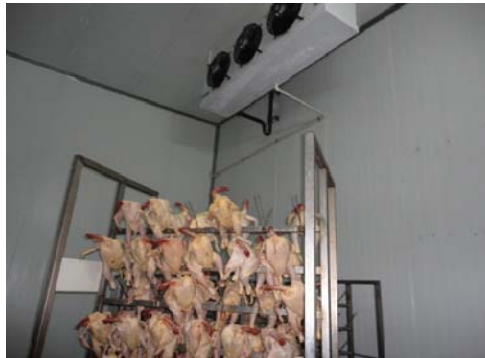
Photo I.8 : les poulets sur les chariots dans la chambre froide de ressuyage
