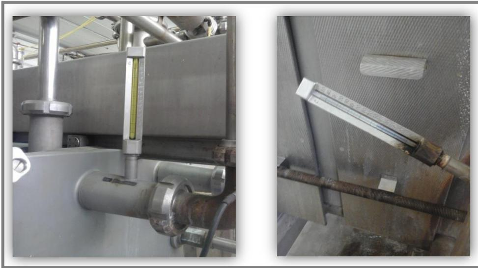
**Figure n °15:** Absence d'étalonnage des thermomètres.
