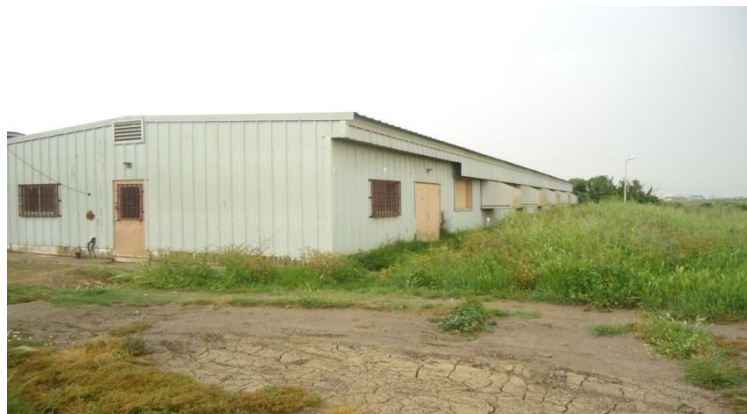
Figure 5: Le bâtiment d'élevage (vue extérieure).
