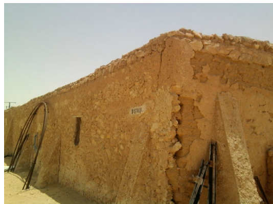
Figure10 : Mur en Toub
