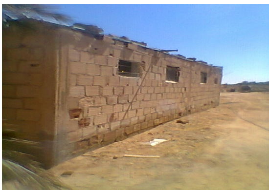
Figure 8 : Mur en brique
