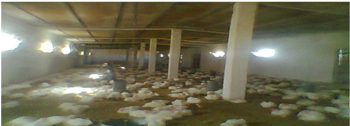
Figure 12 : Toiture en tôle
