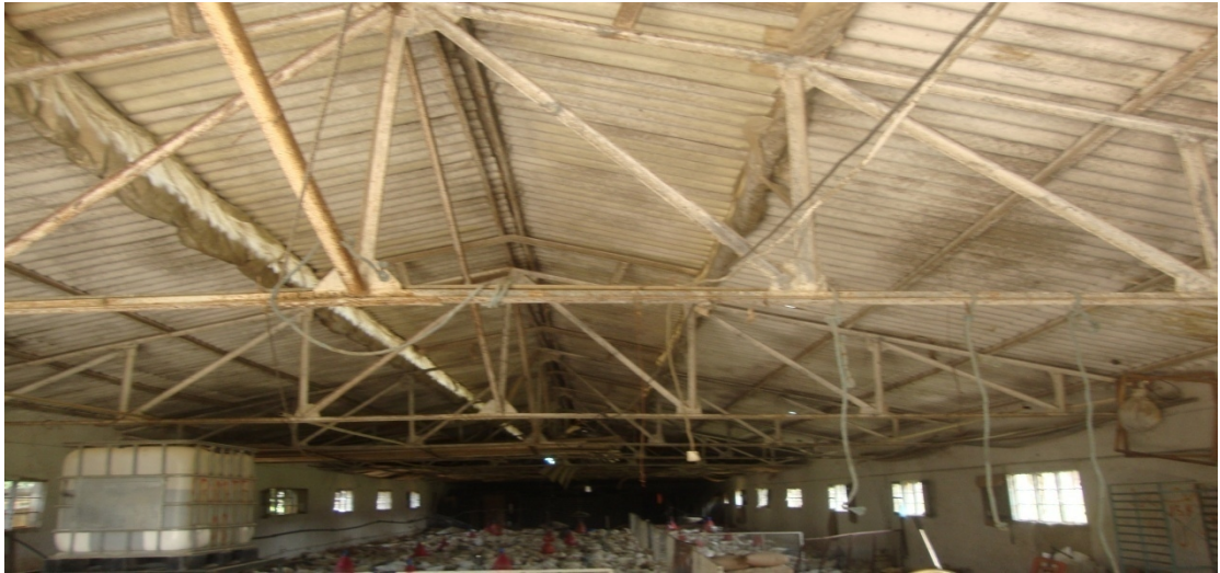
Figure 11 : Toiture en fibrociment
