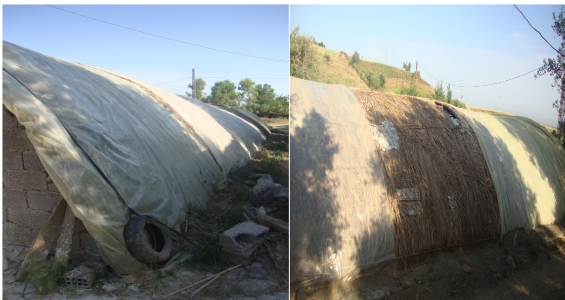
Figure 15 et 16 : isolation des serres en région d'Ain Defla
