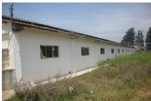
Figure 17 : Bâtiment 01 implanté dans un terrain plat
