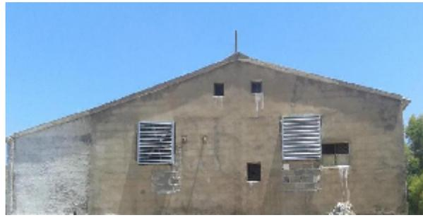
Photo N°03 : les deux extracteurs utilisés dans le bâtiment clair
