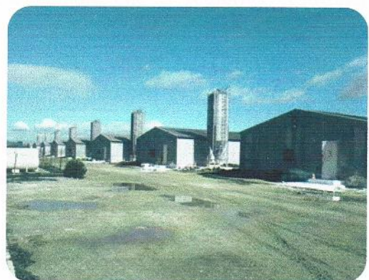
Figure 03 : vue a l'extérieur du C2
