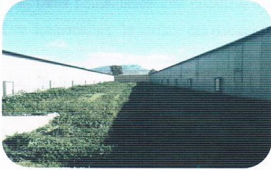
Figure 16 : Vue externe sur les extracteurs
