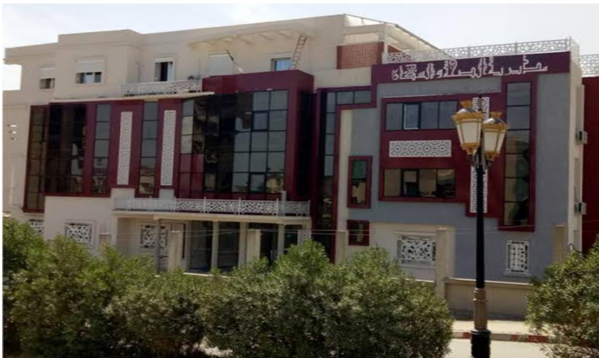
Figure 6 : Photo de la DSP de la wilaya (Cliché personnel, 2020)
