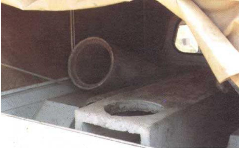
**Figure** - Moine préfabriqué et son conduit (buse) d'évacuation
