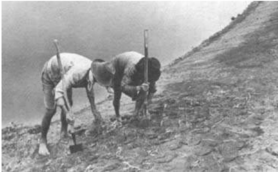
**Figure** - Travaux de finition : engazonnement (MALCOM, 2000)
