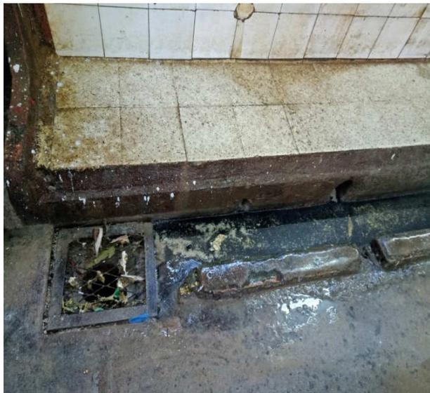
**Figure 18 :** Etat des caniveaux dans la salle de vidange des réservoirs gastriques (photo personnelle)
