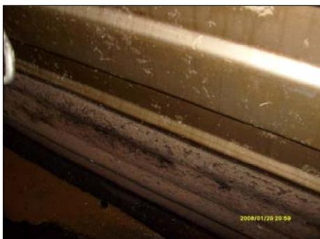
**Figure 15** : Paroi du bac d'échaudage encrassée par des souillures organo-minérales.
