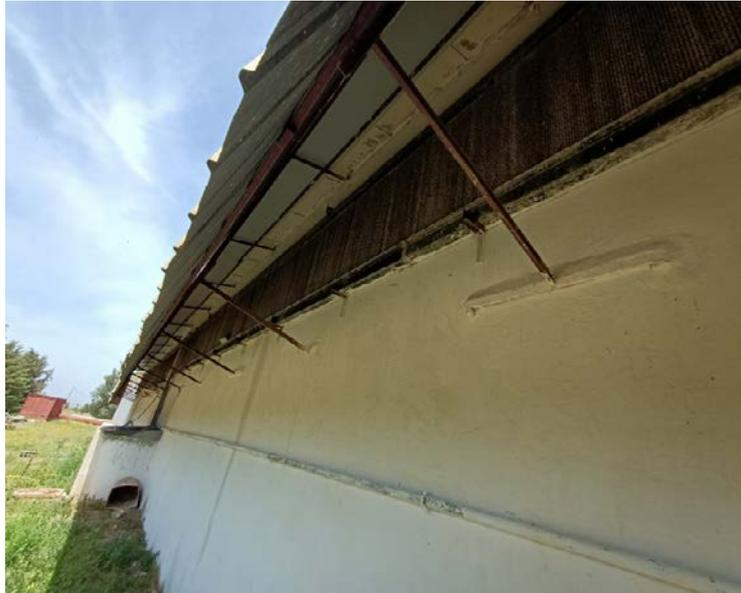
Figure 29 : Humidificateur (pad-cooling) (photo personnelle)
