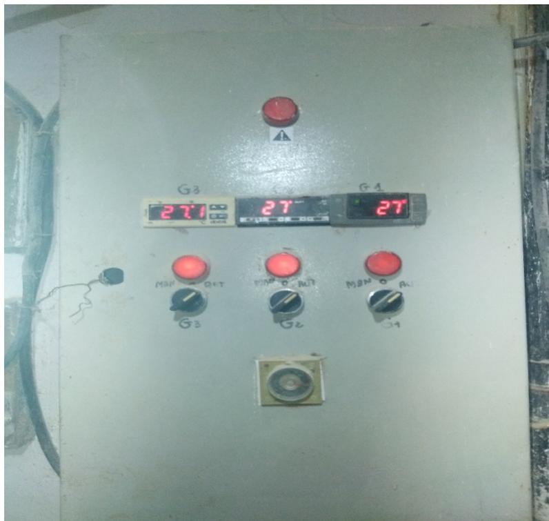
Figure 28 : Thermomètre intégré au tableau de commande (photo personnelle)
