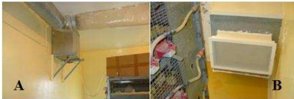
**Figure 22** : système de filtration des animaleries (A : entrée d'air filtré. B : filtre de sortie d'air de l'animalerie)
