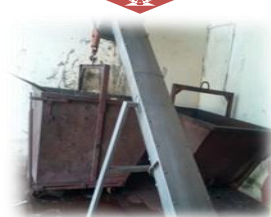
Figure 25: évacuation des déchets
