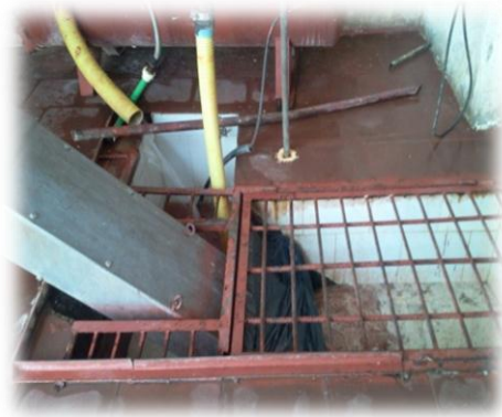
Figure 1 : Evacuation des déchets (Photo personnelle).
