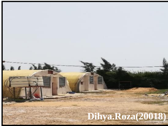
Figure 03 : l'extérieur des deux serres d'élevage
